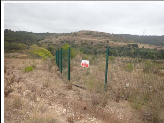
Illustration 3 : Grillage d'enceinte de la station de dépollution et panneau de restriction d'accès
