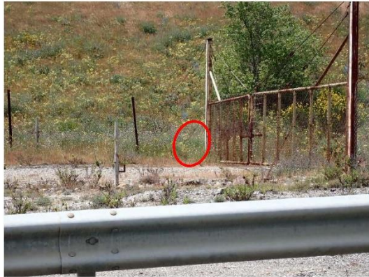
Illustration 48 : Ouverture dans le grillage au niveau de l'ancien portail condamné
