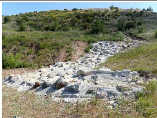
Illustration 40 : Zone de réception des eaux en amont du bassin d'orage, en bon état
