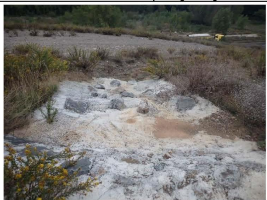
Illustration 16 : Couverture bétonnée et enrochements en bon état
