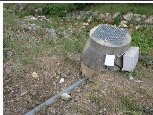
Illustration 35 : Connexion de la canalisation au point V
