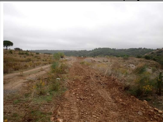
Illustration 15 : Tranchée réalisée à l'occasion des travaux de canalisation des eaux du point V
