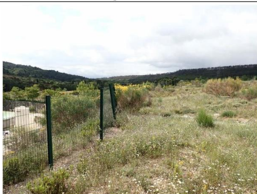
Illustration 17 : Poteaux grillagés penchés le long de l'alvéole big-bag
