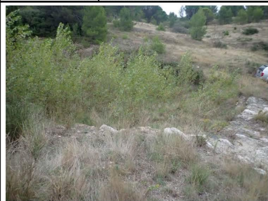
Illustration 30 : Bassin de récupération encombré par la végétation
