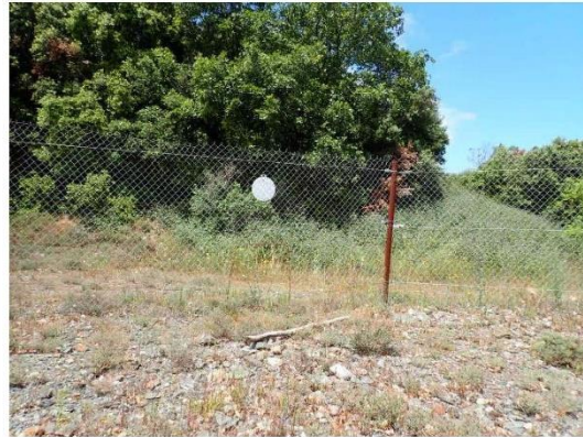
Illustration 49 : Passage faune aménagé dans la clôture
