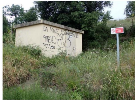
Illustration 26 : Panneau de restriction d'accès en bon état le long de la RD101
