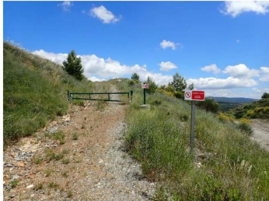
Illustration 1 : Panneaux de restriction d'accès et barrière DFCI au niveau de l'accès à la partie sommitale
