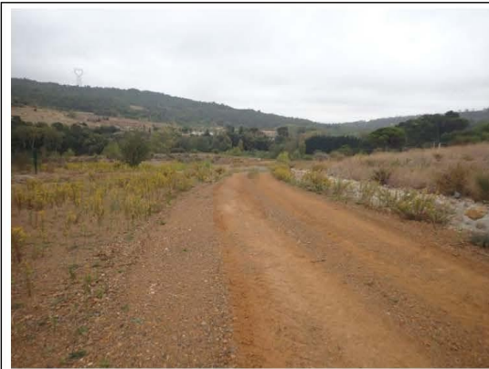
Illustration 1 : Piste de circulation principale, portion en bon état
