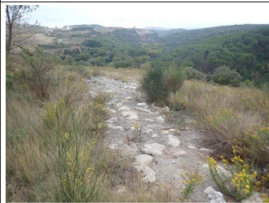
Illustration 28 : Caniveau de gestion des eaux et zone de réception en enrochement
