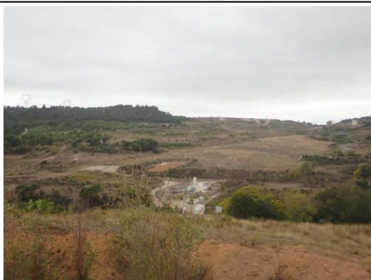
Illustration 11 : Végétation sur la plateforme Nord, au premier plan, l'aivéole big-bag partiellement évacuée fin 2019 et recouverte afin d'éviter les envols de poussières avant la reprise des travaux d'évacuation
