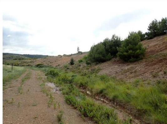
Illustration 16 : Versant séparant les plateformes Nord et Sud, stable
