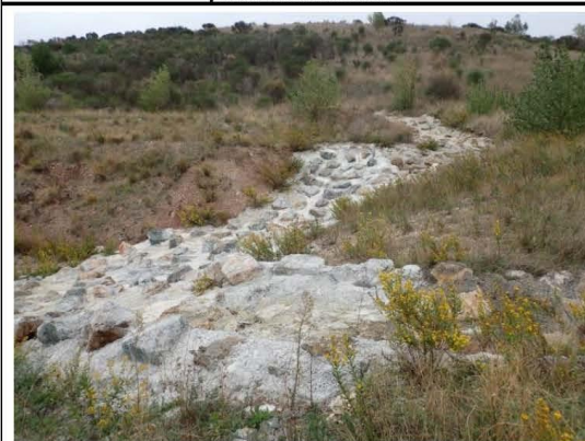
Illustration 29 : Zone de réception des eaux en amont du bassin d'orage, en bon état
