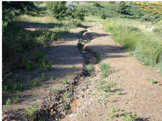
Illustration 38 : Ravinement prononcé de la piste d'accès Nord
