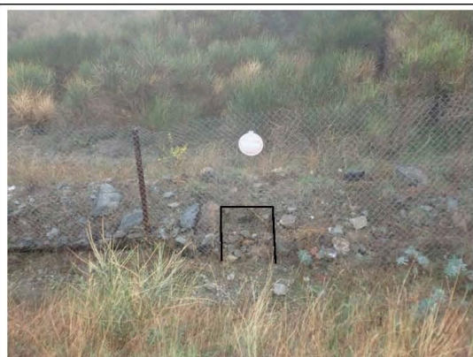
Illustration 38 : Passage faune aménagé dans la clôture
