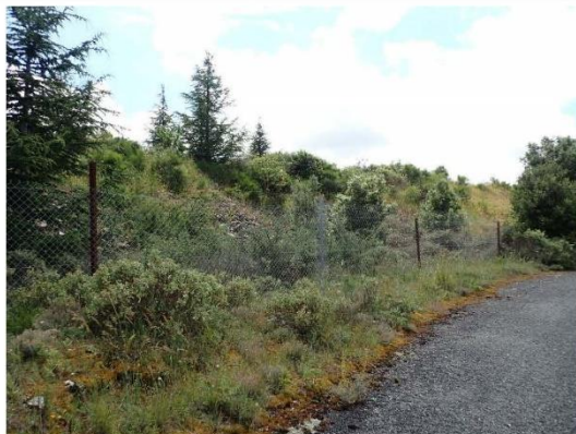
Illustration 50 : Vue de la clôture Nord-Est, panneau de restriction d'accès disparu
